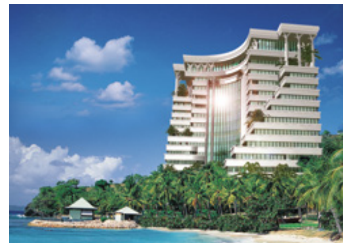
شیشه V-Cool در ساختمان برج میکا در کیش بکار رفته است.
