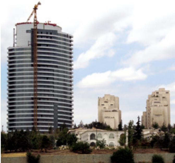
شیشه V-Cool در ساختمان برج مهستان در تهران بکار رفته است.
